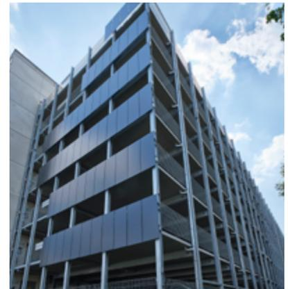
Die Verwendung einer vereinfachten Unterkonstruktion macht die Realisierung der Solarfassade an diesem Parkhaus besonders attraktiv und ist damit wegweisend für die weitere Entwicklung beim Einsatz von BIPV-Fassaden im gewerblichen Bereich.
