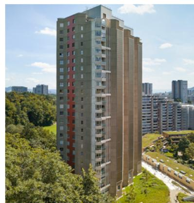
In diesem Schweizer Pilotprojekt bzgl. Brandschutzvorschriften wurden im Rahmen einer Sanierung an 54 m hohen Beton-Fassadenbändern zweier Hochhäuser je eine Solarfassade mit einer speziellen Unterkonstruktion in die Gebäudehülle eingebunden.
